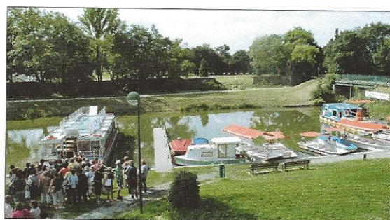
Bat'ův kanál – původně byl vybudován pro nákladní dopravu. Dnes je to zajímavá turistická atrakce.
